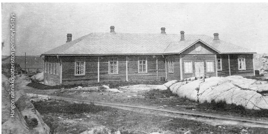
Vanha konttori- ja asuinrakennus, jossa oli myös sotilaskoti.
